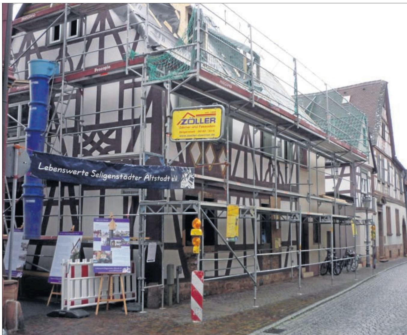
Am Beispiel der aktuellen Sanierungsmaßnahme eines Vereinsmitgliedes in der Steinheimer Straße 20 informierte der Verein „Lebenswerte Seligenstädter Altstadt“.
